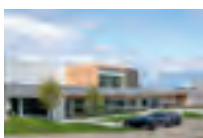
Centre sportif 635, avenue Baillairgé
